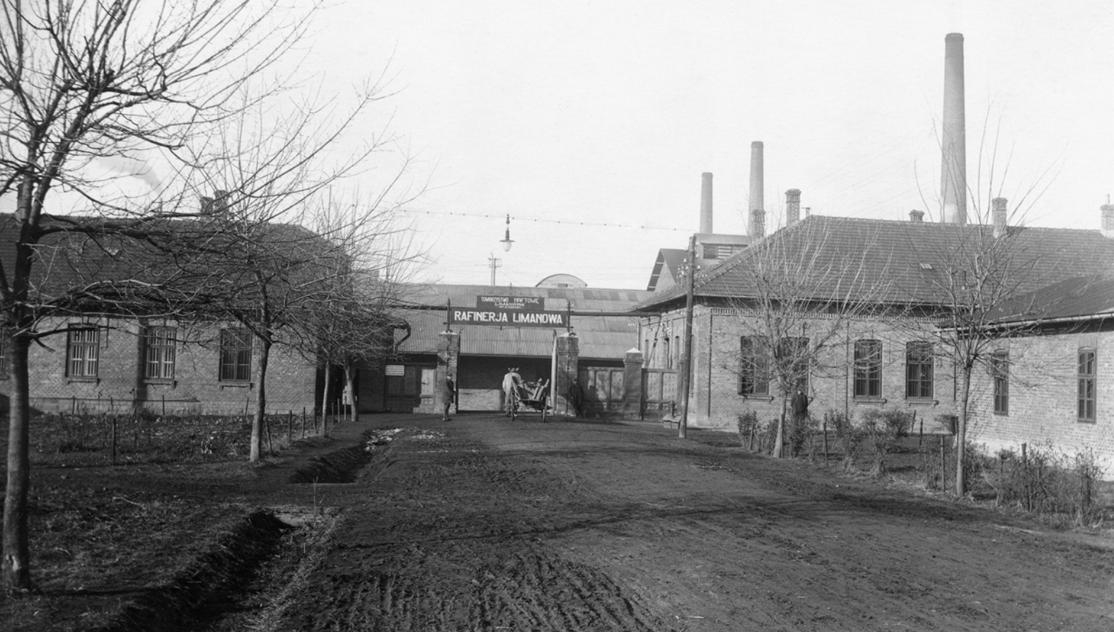
Brama wejściowa do rafinerii w Sowlinach.
