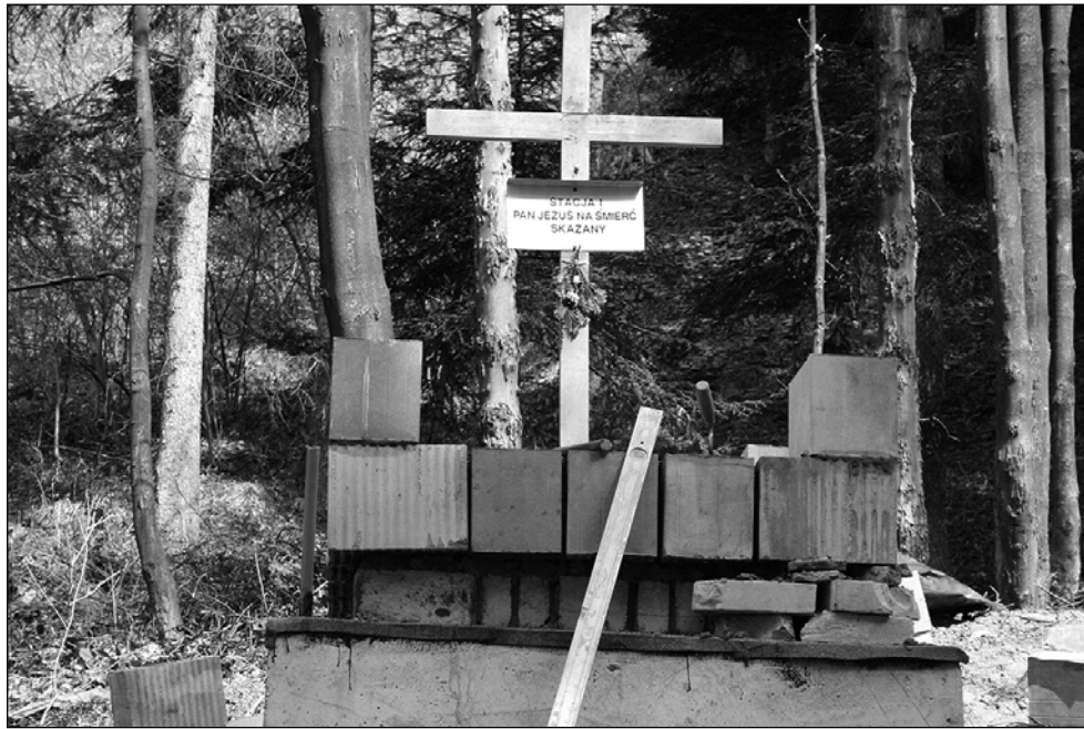
W maju 2010 r. przystąpiono do realizacji projektu. Budowę kapliczek wykonała firma ALP-BUH Lilianny i Pawła Peciak.
