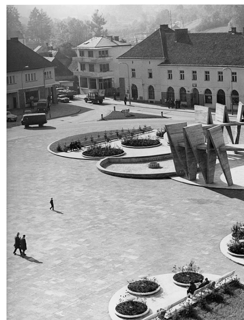
Odmienne oblicze rynku - limanowski rynek po jego przebudowie z rzeźbą plenerową tzw. „buzodromem”. Fotografia wykonana z budynku po stronie północnej w kierunku
