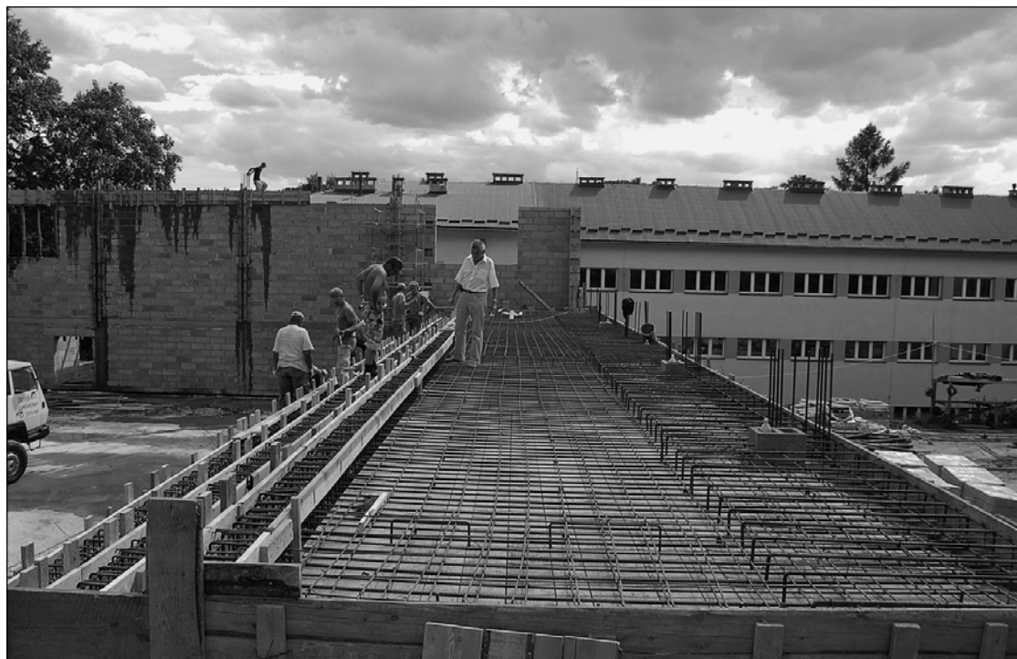
Prace budowlane prowadzone były pod nadzorem inż. Stanisława Chrobaka.
