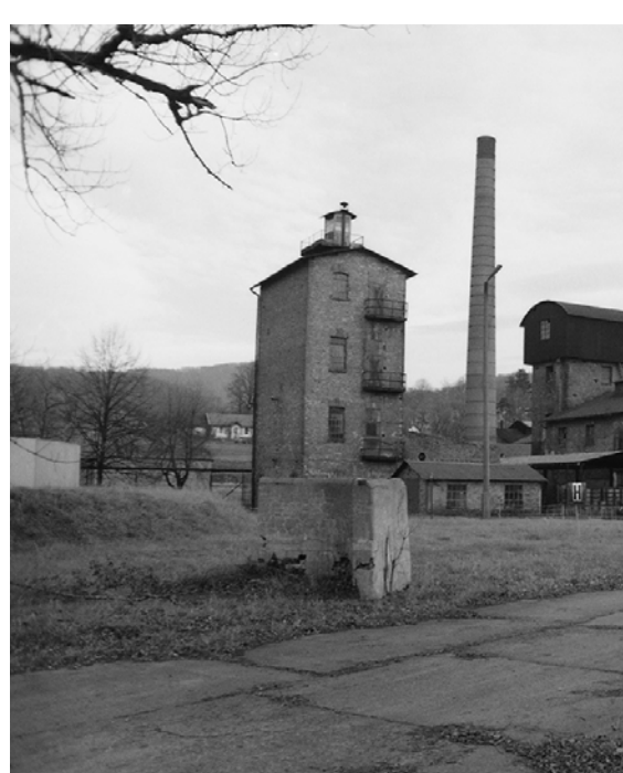
Galicyskie ślady - pozostałość zabudowań rafinerii w Sowlinach.
