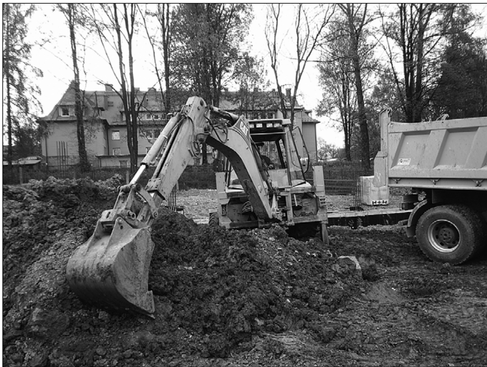
Rozpoczęcie prac ziemnych - „pierwsze kopnięcie”.
