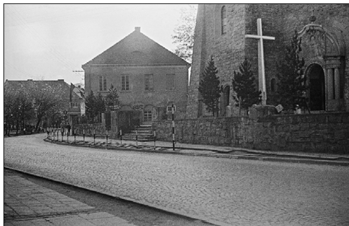
Po demontażu figury widoczny pozostały cokół. W tym czasie rozpoczął się generalny remont na placu przed kościołem - 1970 rok.
