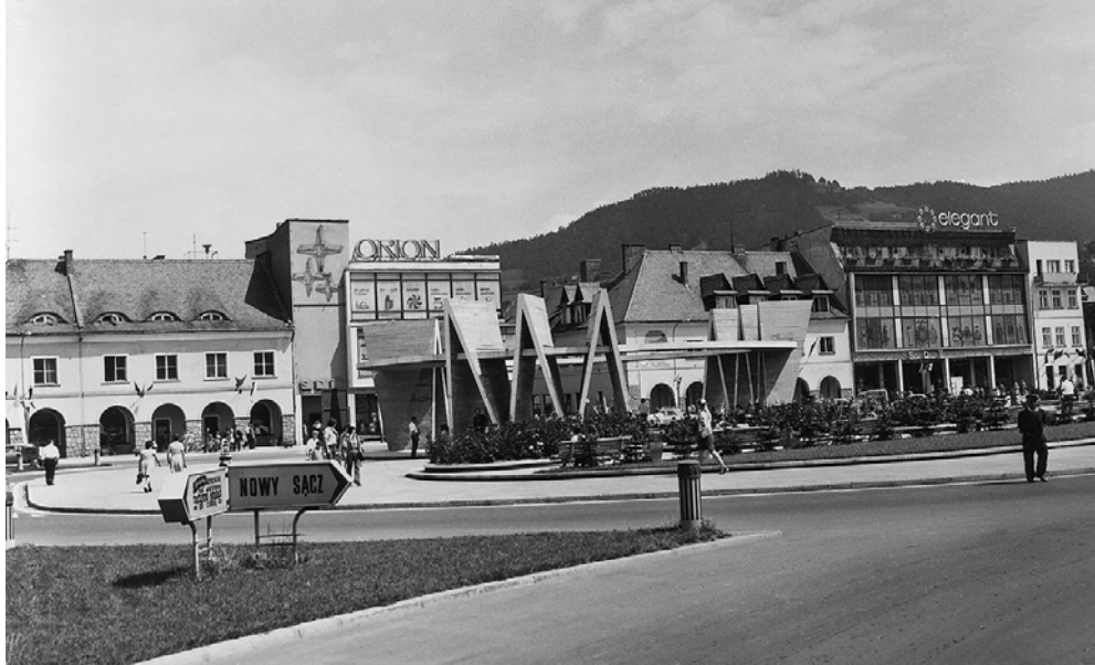
„Podcienia murowane” rozpoczęto budować po 1956 roku. Północna strona rynku zapoczątkowała nowy układ urbanistyczny miasta.
