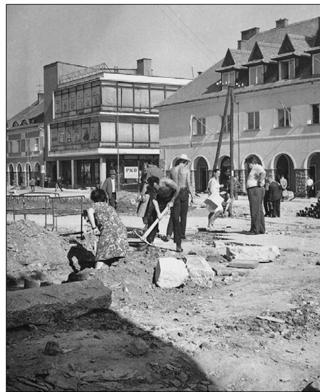
Przebudowa rynku w latach 1971-72. Większość prac wykonywano w „czynie społecznym”.
