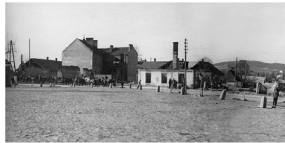
Widoczne gruzy pogorzeliska północnej części rynku po pożarze
