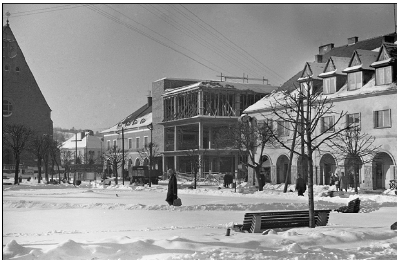
Budowa Domu Towarowego w Limanowej.
