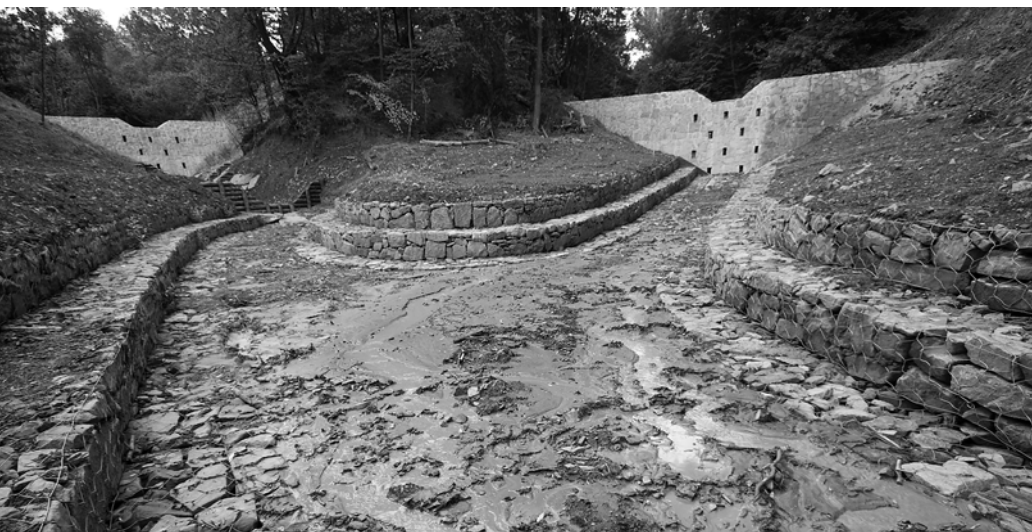
Stabilizacja osuwiska przy ulicach Słonecznej i Paderewskiego - zapory przeciwrumowiskowe.
