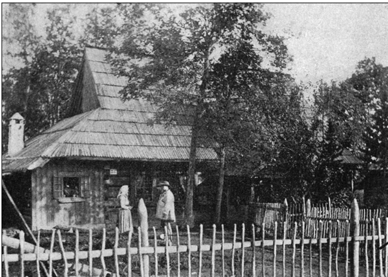
Dom Sobczaków przy ul. Kościeliskiej - chata góralska składająca się z dwóch segmentów: białej i czarnej izby, rozdzielonych sienią - zdjęcie z 1901 roku.
