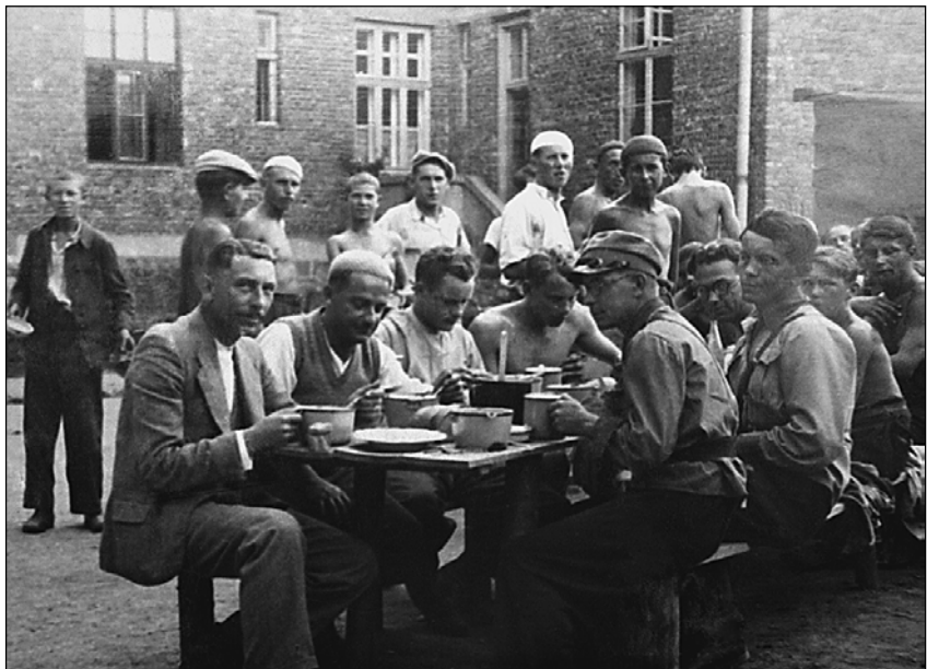
Wspólny obiad robotników (ochotników) usuwających szkody po powodzi w 1934 roku. Robotnicy zakwaterowani byli w nowo wybudowanej szkole (dziś ZSS nr 1). Pierwszy od lewej siedzi Stanisław Ceglarz - długoletni kierownik tej szkoły.
