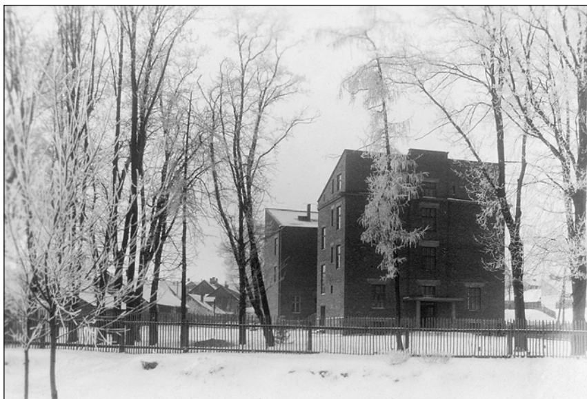
W 1925 roku podjęto odważną, ale i oczekiwaną decyzję budowy nowej szkoły. Ta największa inwestycja tego okresu zablokowała na pewien czas inne. Do budowy przystąpiono 4 lipca 1929 roku, a całość wykończono w 1933 roku. Szkoła mieściła się w ogrodzie miejskim, a jej lokalizację wskazał ówczesny burmistrz Marceli Bursztyn. Fotografia z 1938 roku.
