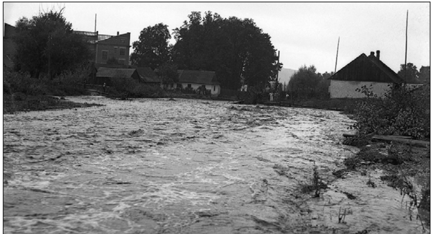
Rozlane wody potoku Mordarka. Po lewej stronie nowo wybudowany budynek szkoły.
