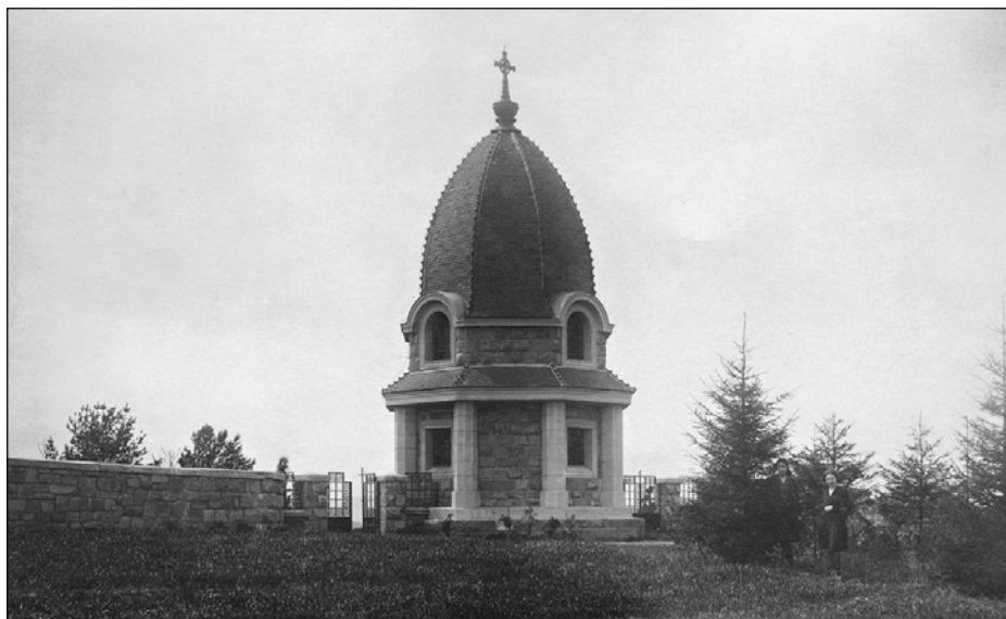
W latach 1915-18 zbudowano na Jabłońcu cmentarz wg. projektu Gustawa Ludwiga.
