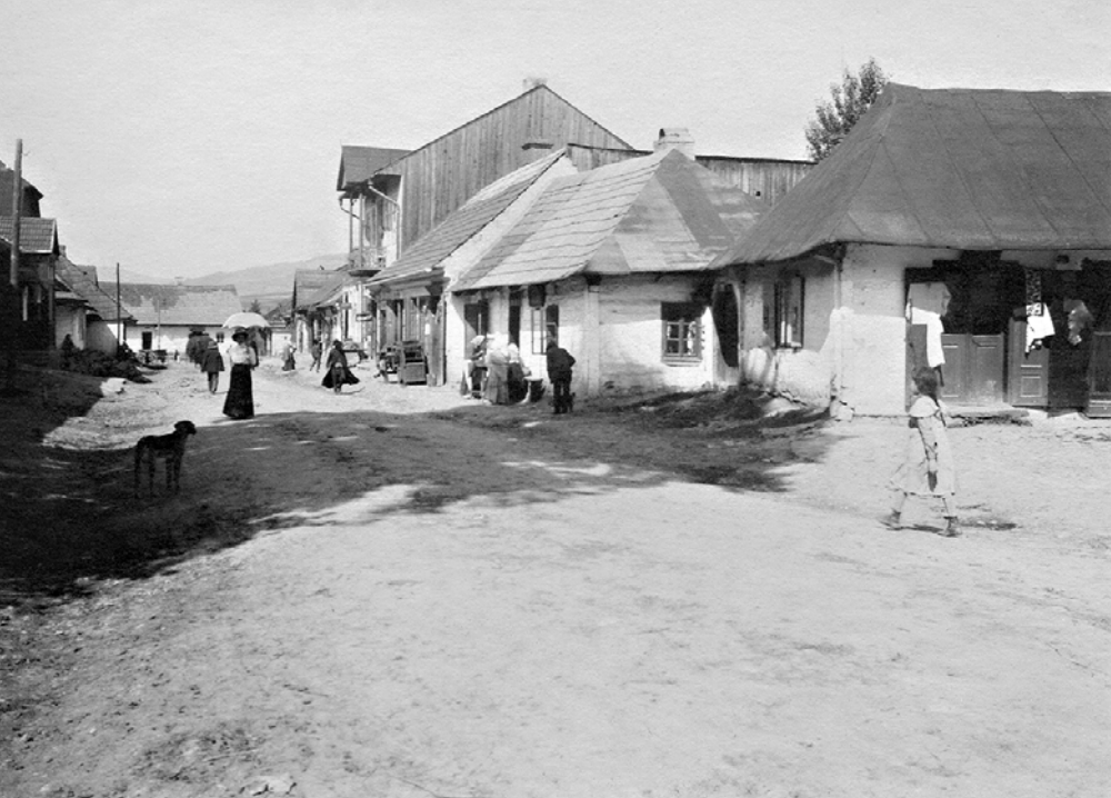
Drewniane domy budowane na zręb z pobielonymi ścianami i niskimi dachami, pierwotnie kryte gontem - to ulica Krakowska na początku XX wieku.
