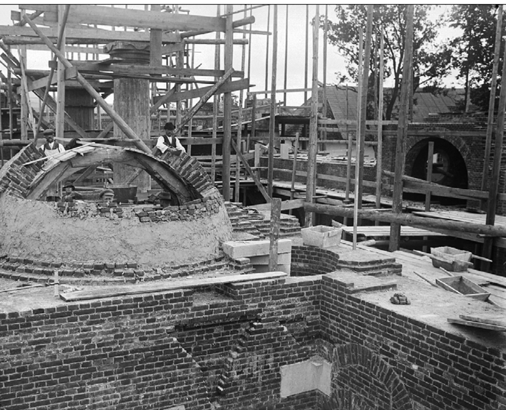
Murarze przy łuku arkady ołtarza bocznego (św. Józefa), z tyłu, wśród rusztowań widoczne kolumny z kapitelami. Fotografie Klementyny Zubrzyckiej.
