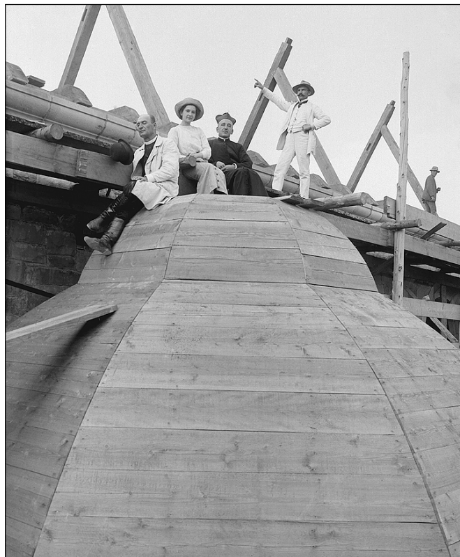
Na odeskowanej kopulce kaplicy przygotowanej do pokrycia. Siedzą od lewej: ks. Kazimierz Łazarski, Wiktorina Zubrzycka. Stoi Jan Śmierciak.
