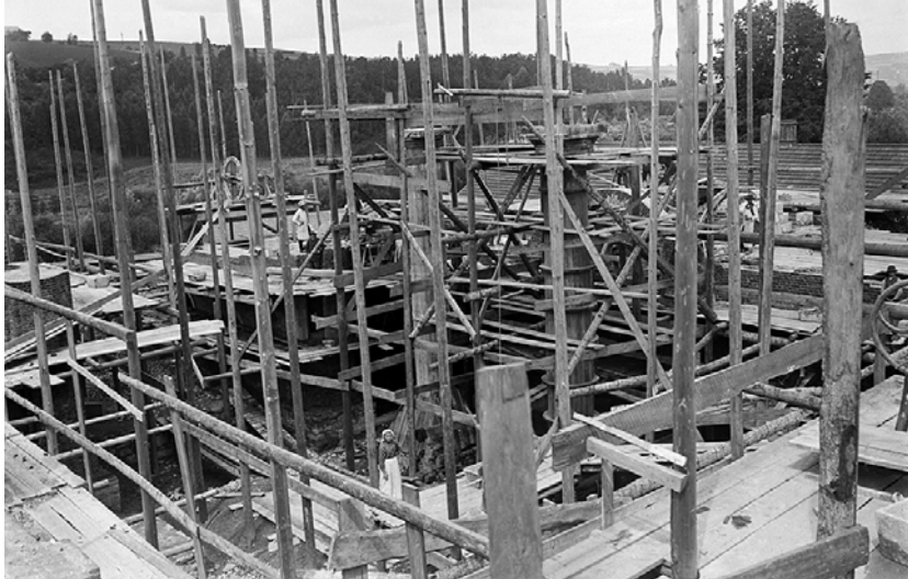
Las rusztowań oplutł powstającą w imponującym tempie budowlę.
