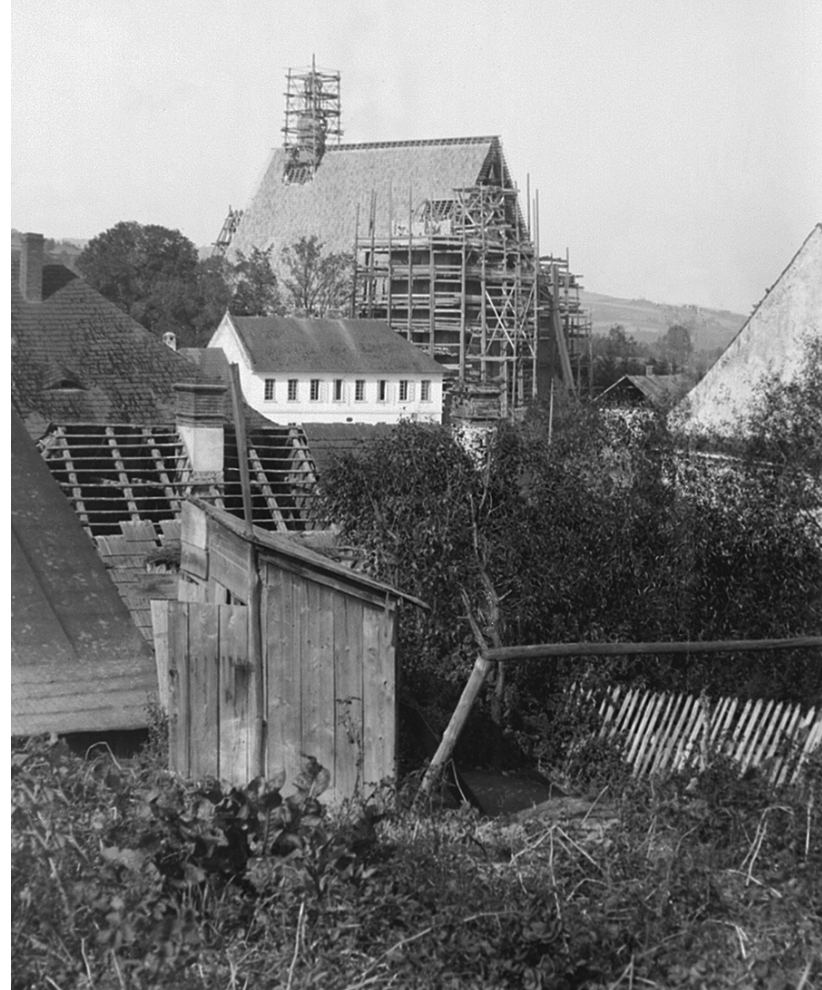
Widok od strony południowo-wschodniej na budujący się kościół (na pierwszym planie tradycyjne zabudowania limanowskie).
