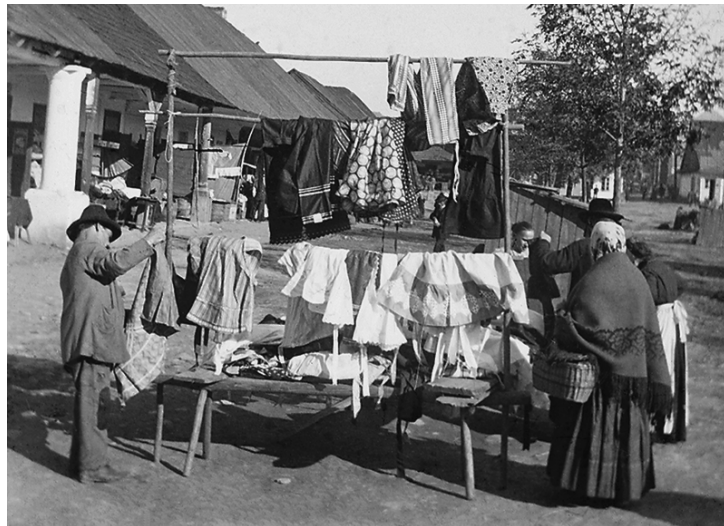
Stragan z odzieżą obok podcieni, które na przestrzeni lat zmieniały swój wygląd. Na fotografii widoczne charakterystyczne masywne podpory, które w latach międzywojennych zastąpiono prostymi słupami.
