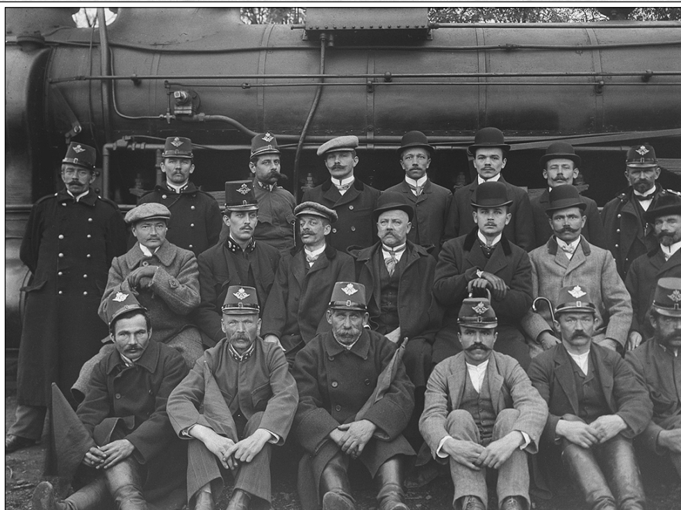
W latach 1882-1885 austriackie Cesarsko Królewskie Koleje Państwowe wybudowały nową drogę żelazną zwaną Galicyjską Koleją Transwersalną. Załoga stacji kolejowej w Limanowej w 1916 r. na tle austriackiego parowozu serii 73.
