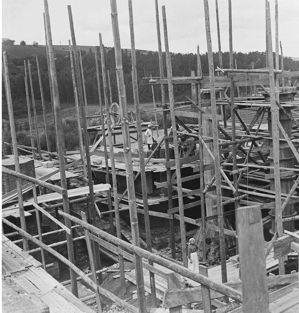
Pośród „jasu” rusztowań widoczne są pierwsze kolumny limanowskiego kościoła.
