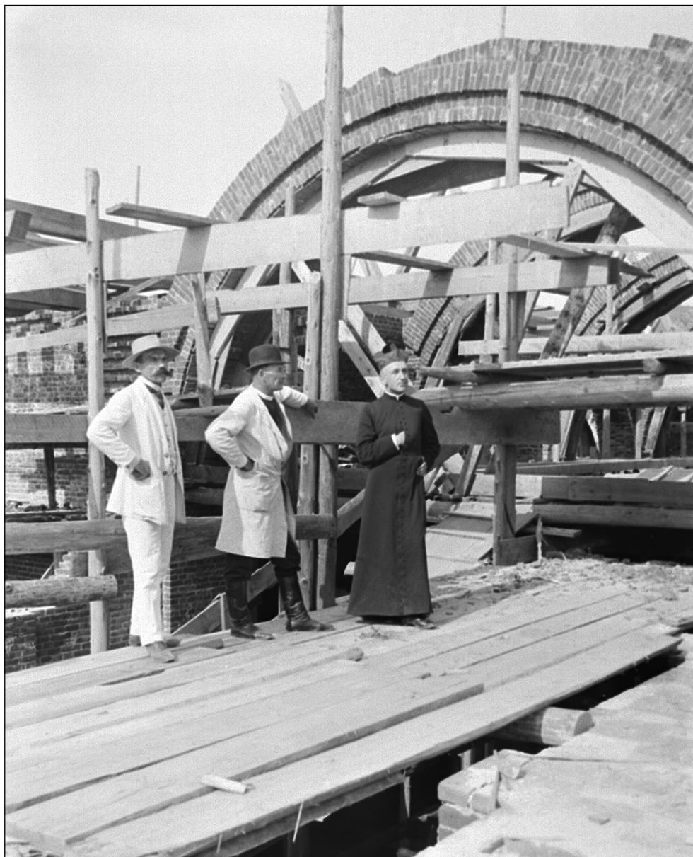
Kierownik budowy z ks. K. Łazarskim (obok nierozpoznany ksiądz) na rusztowaniach budującego się kościoła.
