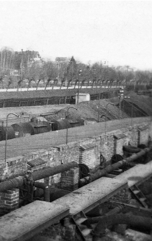
głównie z Borysławia. W tle widoczne są wille kierownictwa
