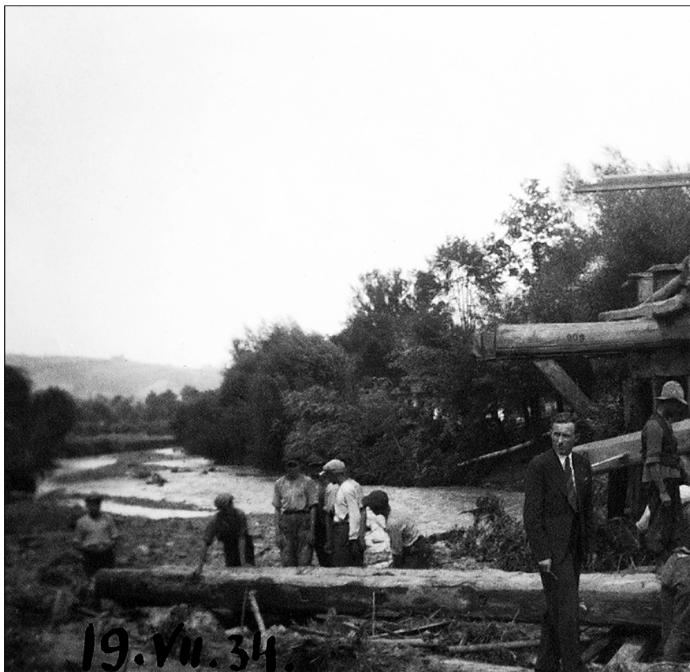
Most na potoku Mordarka na głównej ulicy w Limanowej (dziś Jana Pawła II) po powodzi w 1934 r.
