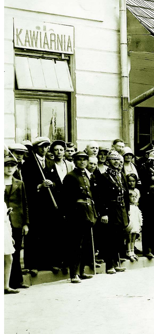
Przed budynkiem limanowskiego magistratu, który w latach
