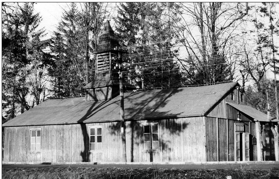
Kaplica-barak. Rozbiórki dokonano w 1996 r.
