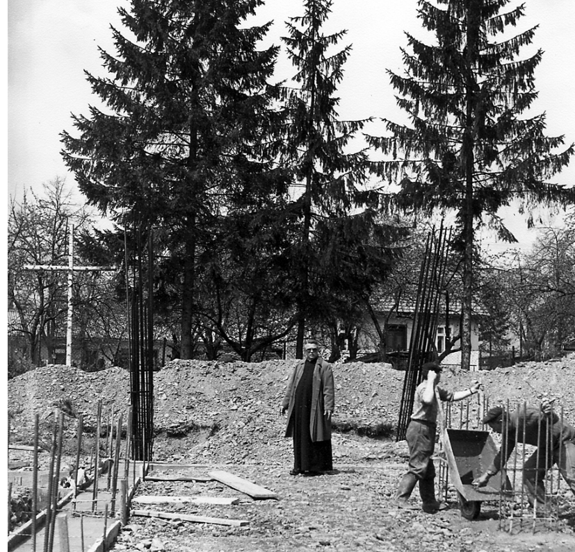
Na placu budowy - ławy już z wyrównanym terenem - 1981 r. Z lewej strony widoczny charakterystyczny brzozowy krzyż, poświęcony przez bpa Jerzego Ablewicza 16 kwietnia 1978 r. jako początek budowy kościoła.
