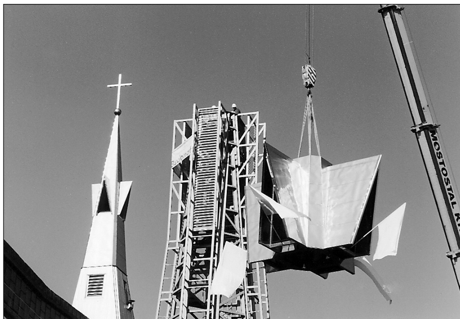
Ostatnim etapem budowy kościoła było postawienie wieży z sygnaturką - 2004 r.
