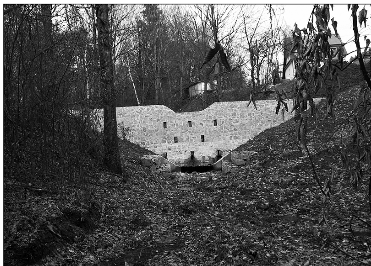
Zapora w górnej części potoku zabezpieczająca ulicę Partyzantów.
