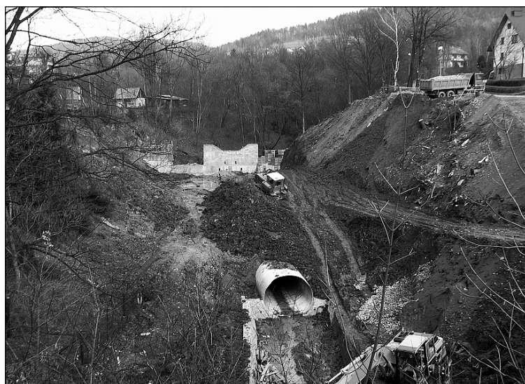
Zapora przeciwośuwiskowa ubezpieczająca brzegi potoku przy ul. Paderewskiego. Na dnie doliny widoczny stalowy przepust, który przykryty będzie nasypem.
