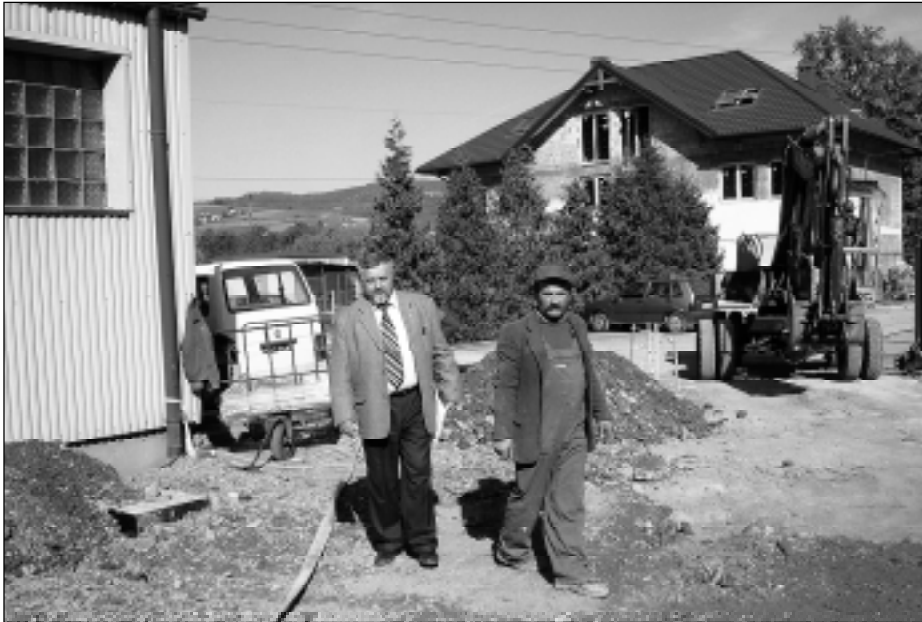
W czasie prac przy budowie nowej hali magazynowej.
