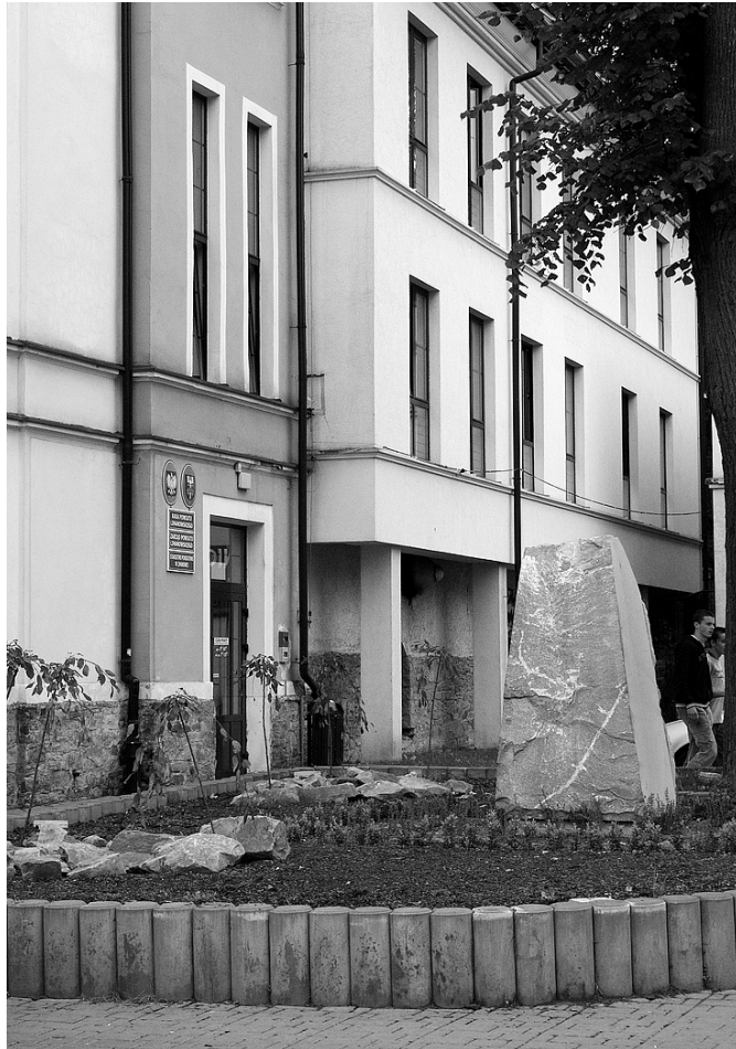
Cokół pod obelisk czynu inż. Józefa Marka na skwerze przy Starostwie Powiatowym w Limanowej.
