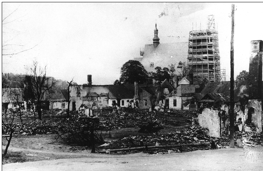
Budowa kościoła w Limanowej. Na pierwszym planie zniszczenia po pożarze.
