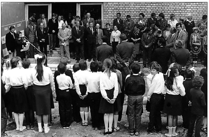
Uroczystość wmurowania kamienia węgielnego pod pod nową część budynku szkoły. - 1986 r.
