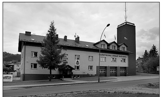
Ogólny widok strażnicy PSP w Limanowej.
