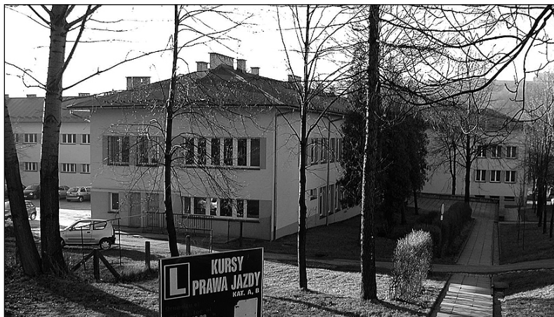
Budynek I LO po rozbudowie i modernizacji.
