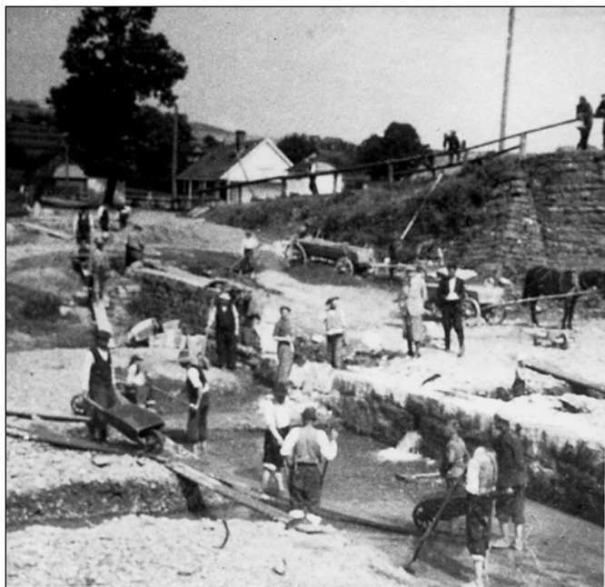
Regulacja potoku Mordarka w 1942 r. - umocnienia przy moście.
