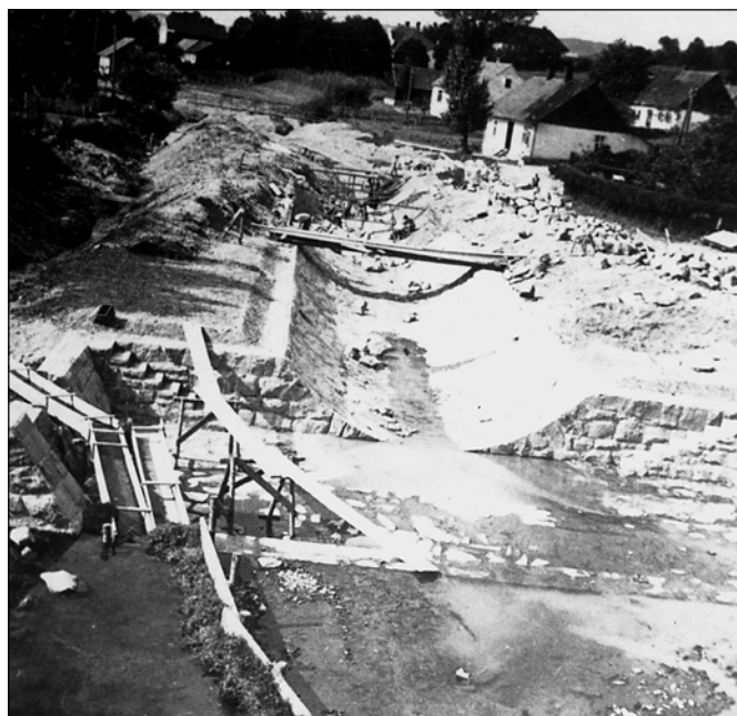
Regulacja potoku Mordarka w 1942 r. - kamienne progi przy moście.
