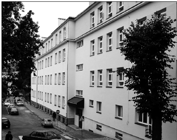
Budynek Zespołu Szkół Samorządowych nr 1.
