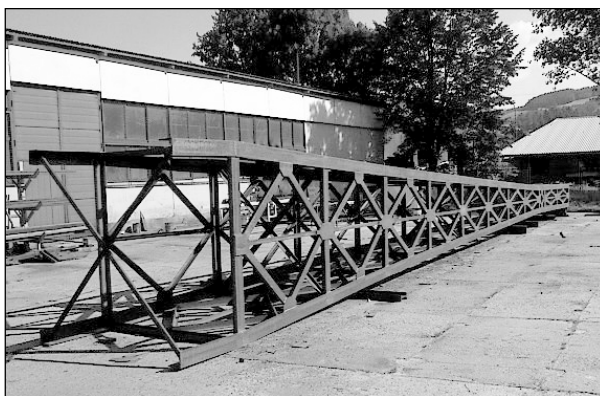
Konstrukcja krzyża, który ma być posadowiony na górze Paproć.
