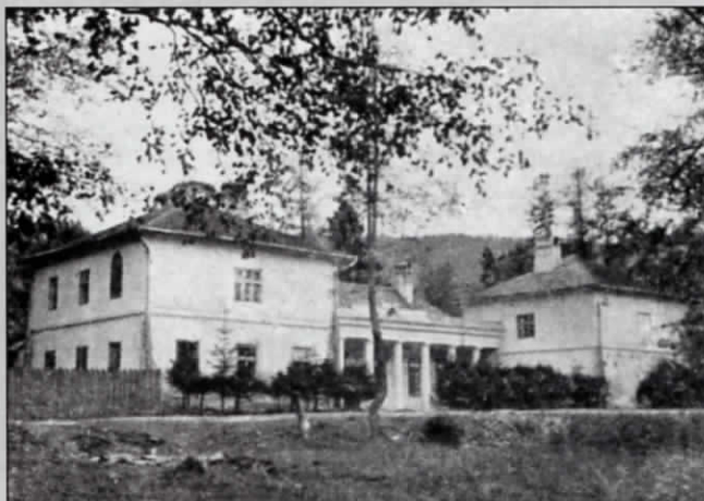
Pałac w Kamienicy - widok od frontu.
