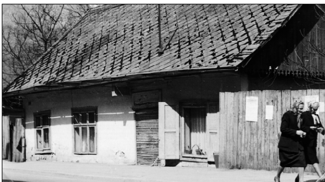
Tu była pierwsza spółdzielcza restauracja (dom p. Panczerza) przy ul. Orkana (obecnie ul. M.B. Bolesnej). Dziś w tym miejscu prowadzone są roboty budowlane.
