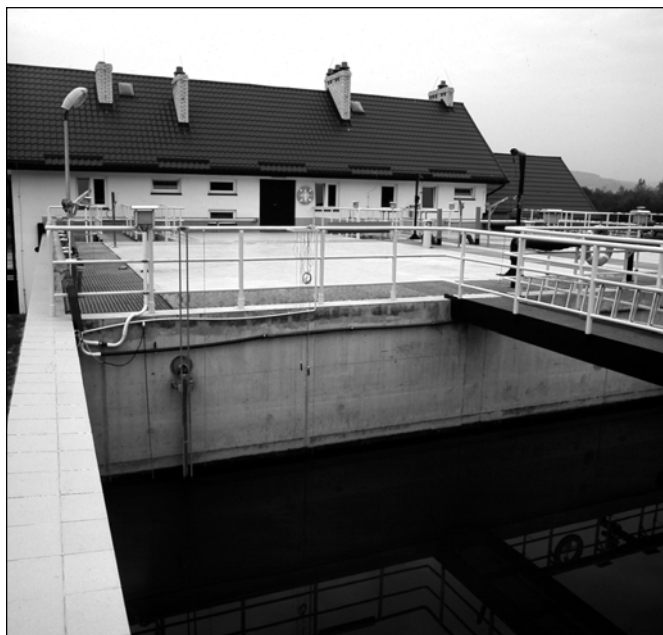
Oczyszczalnia ścieków w Peimiu - wykonawca firma Wolimex.
