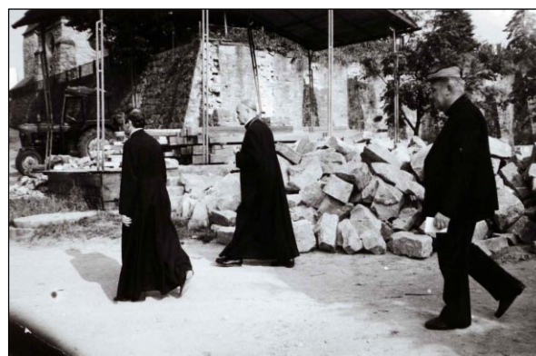
Budowa na Placu Koronacyjnym limanowskiego kościoła.
