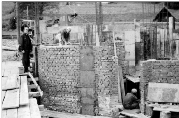
Na placu budowy kościoła w Starej Wsi.
