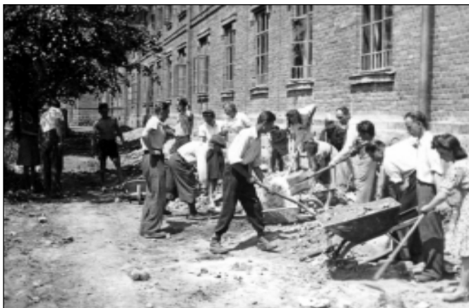
Prace porządkowe przy budynku liceum w Sowlinach.
