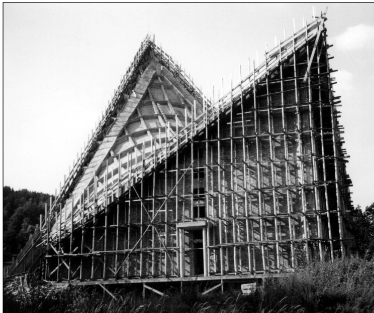
Roboty budowlane przy górze kaplicy (fot. arch. parafii).
