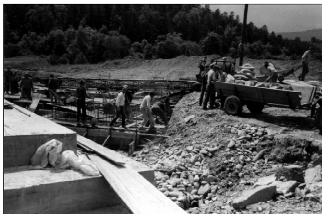
Rozpoczęcie prac betonarskich - lanie ław (fot. arch. parafii).
