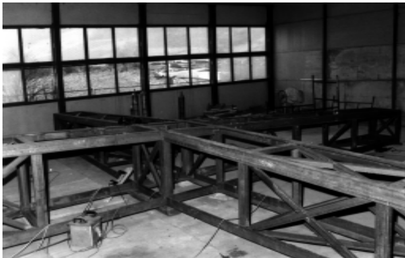
Konstrukcja Krzyża - Ujanowice 19. 01. 1999 r.
