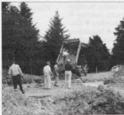
Prace budowlane przy fundamentach Krzyża.
