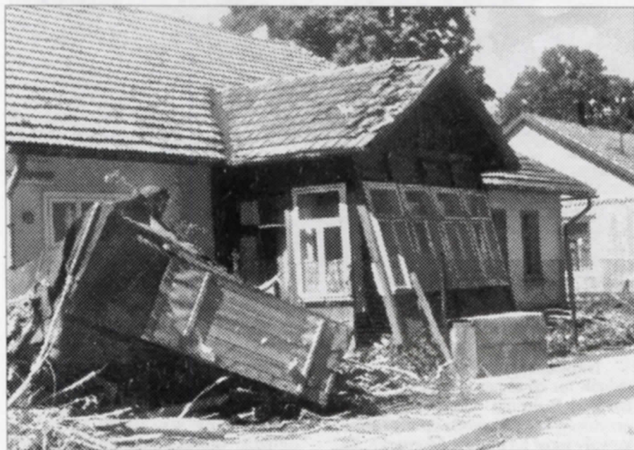
Zniszczony przez wodę dom przy moście na ulicy M.B.Bolesnej 46
