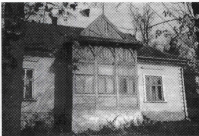
Dom u zbiegu ulic: Słonecznej i Piłsudskiego, w którym mieszkają rodzina Beków
