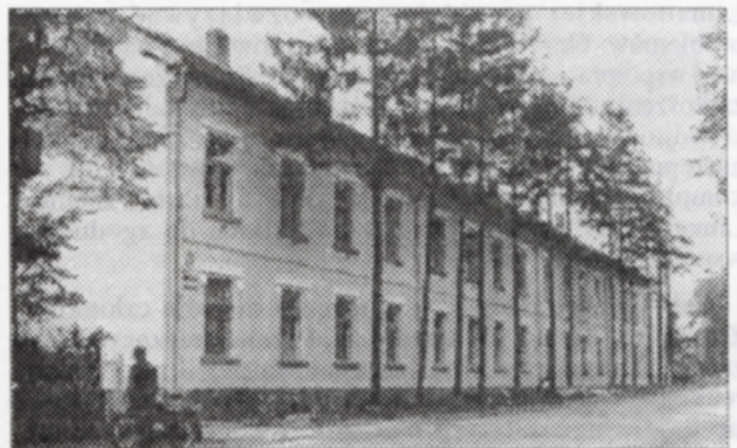
Z tego budynku 28.08.1939r. wymaszerował Batalion ON "Limanowa".
